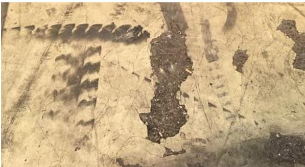
Auf diesem Bild ist ein Exemplar einer Bodenplatte, die nicht von Futura geplant und ausgeführt wurde, zu sehen. Diese wurde nicht auf die Nutzlasten der Halle abgestimmt.
